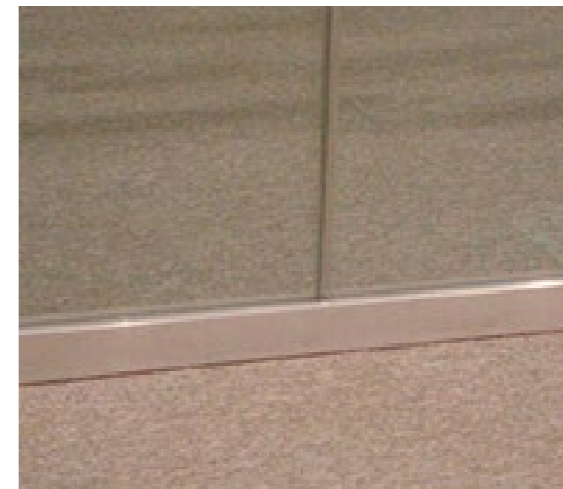
Fissaggio pavimento /soffitto, guarnizione pvc, giunto policarbonato.
